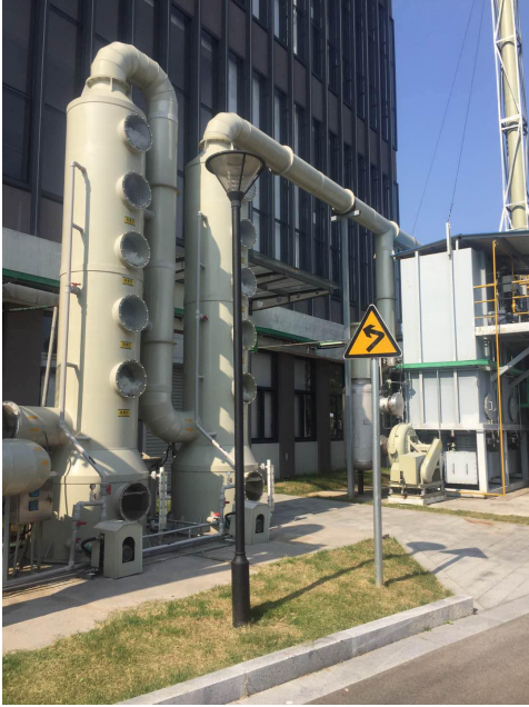
RTO 焚烧系统喷淋塔
